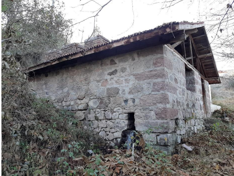
EK 13: Fotoğraf 10 - Belören Köyü II No'lu Çamaşırhane Kuzeydoğudan görünüş
