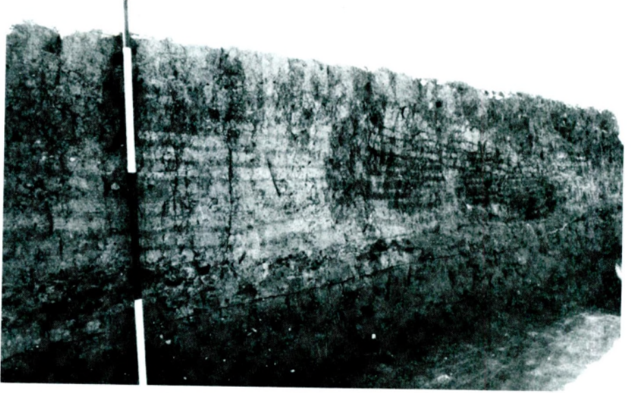
Levha 12/2 - Tranşenin güney kenarında izlenen duvar (KAD).
