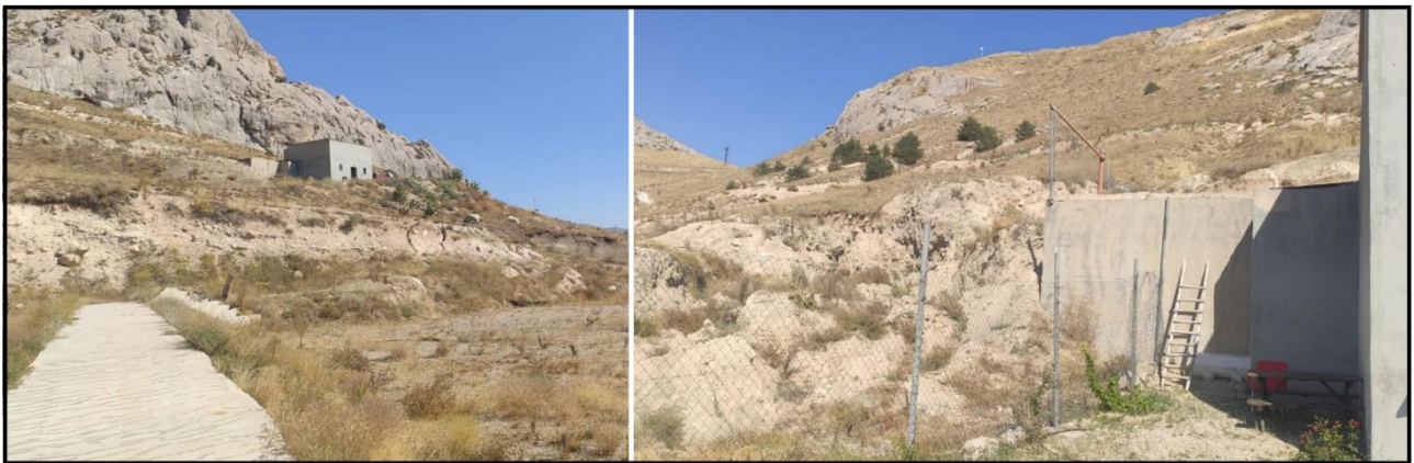
Şekil 3. Çalışma alanı içerisinde bulunan su deposu ve su deposu civarının görünümü
