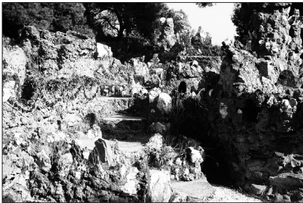
Resim-15: Paşa Bahçeleri Merdivenlerinin Genel Görünüşü (Foto: Neval Konuk, 2009)
