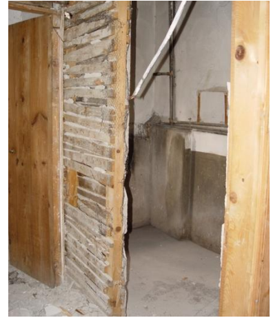
Resim 17. Betenler Evi, Safranbolu’da “desteksiz açıklıkta” bağdadi uygulaması.
