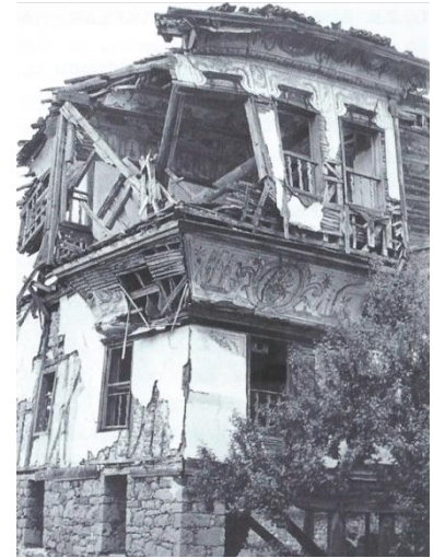
Resim 18. Çanakkale Adatepe’de Ev (Tayla 820 r. 484B) Zemin katı taş kagir, birinci katı tuğla dolap, ikinci kat ahşap ve bağdadi.
