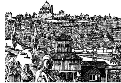
Resim 16. Bir Çatma Ev ve Cihannüması (Ahşap oyma Cöcke van Älst, The British Library, Londra, BM 146.1.10). Sünnet Alayından ayrıntı, 1509 Büyük İstanbul Depreminden 20 yıl sonra Fatih Camisi, 2 minaresi de yıkık, 1529 gibi.
