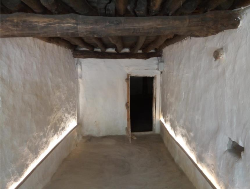
Resim 4) Küçük Ocak (Şeyh Bahşiş) Zaviyesi Girişi
