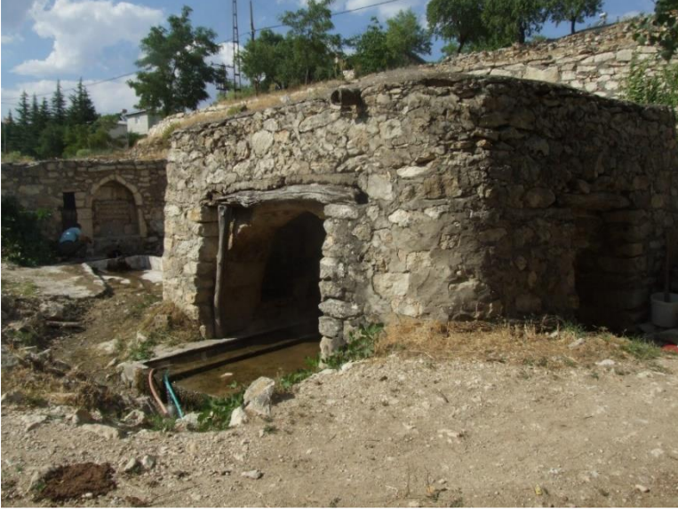
Resim 8) Onar köyü baldeken yapı dış cephe
