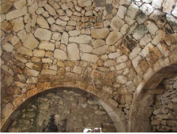
Resim 10 Onar köyü baldeken yapı üst örtü
