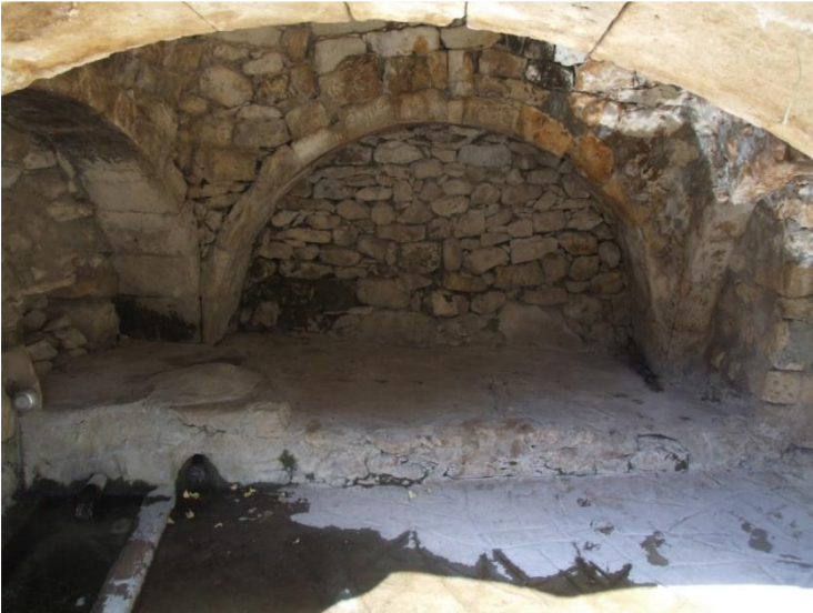
Resim 9) Onar köyü baldeken yapı iç mekan
