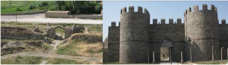
Şekil 26,27. Eski Van Şehri Saray Kapısı Onarım Öncesi ve Sonrası Görünüşleri (Ş. Öztürk)
