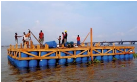
Şekil 1 a. Yapının zeminini oluşturan platform (URL 2)
