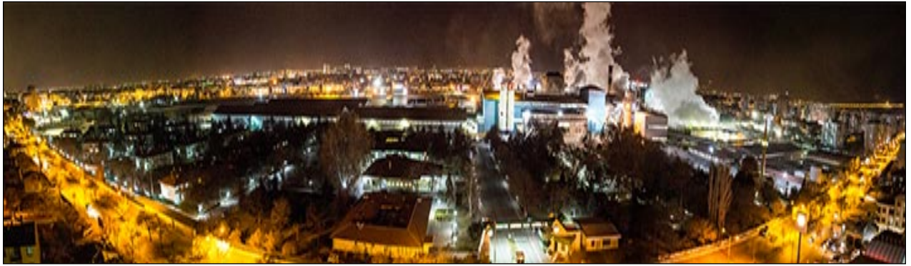
Şekil 4. Konya Şeker Merkez Kampüsü -gece görünüm (Url 6)
