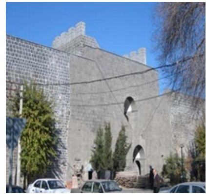
c. Taş duvara sıva uygulaması
