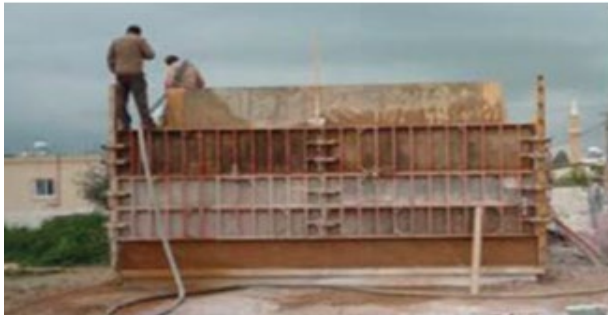
Şekil 11 a. Çelik kalıp kullanımı (Işık, 2020)
