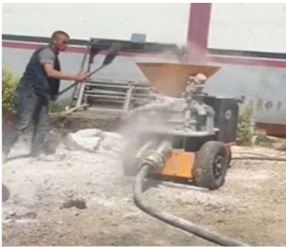
Şekil 13 a. Shotcrete makinesi kullanımı
