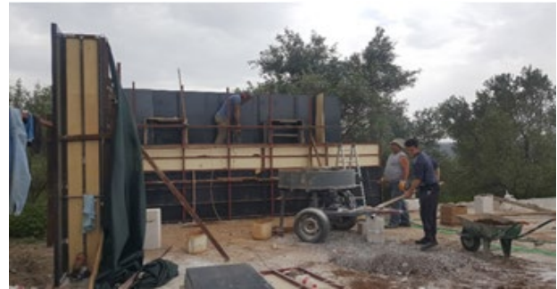
b. Ahşap kalıp kullanımı (Aysel Tarım)
