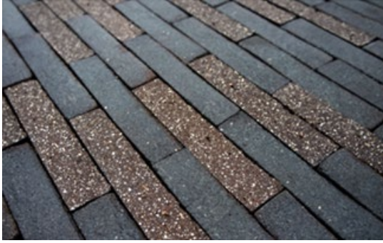
Şekil 4 a. Atık inşaat malzemelerinden geri dönüşüm ile elde edilen zemin kaplama malzemesi b. Tuğla örnekleri (URL 3)
