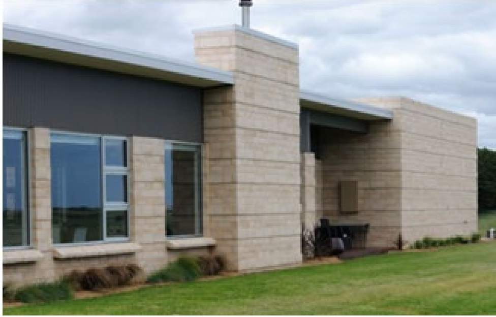
Şekil 10. Kereste beton (Timbercrete) malzemesinin yapıda kullanımı (URL 13)
