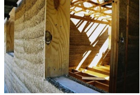
c. Kenevir betonun duvarda kullanımı
