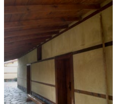
c. Duvarda hatıl kullanımı (Bektaş, 2019).
