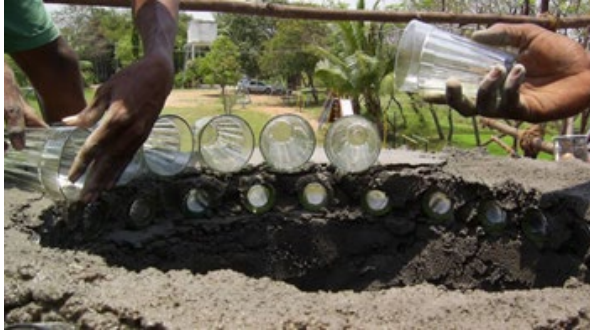
Şekil 3 a. Cam bardakların yapıda kullanımı
