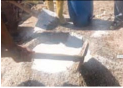
Şekil 12 a. Toprağın döküm öncesi katkılarının ilave edilmesi
