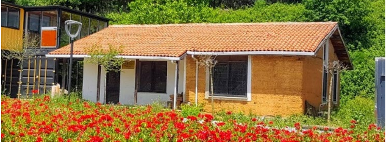
Şekil 17. İTÜ Ayazağa kampüsünde kerpiç yapı (Bilge Işık)
