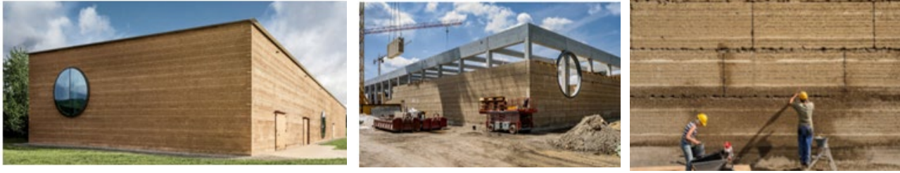
Şekil 21 a. yapının genel görünüşü (URL 22) b. Betonarme strüktür (URL 22) c. duvarda kerpiç blok kullanımı (URL 22)
