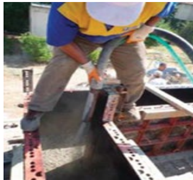
b. Püskürtme yöntemi ile duvar yapımı (Işık, 2020)
