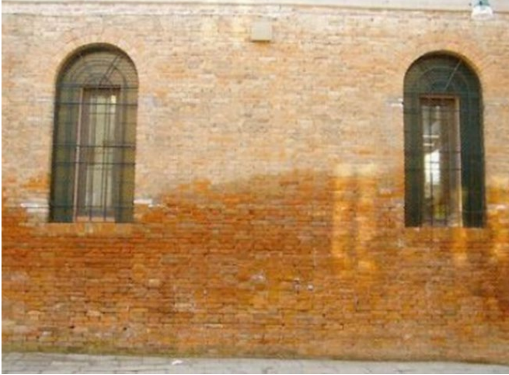
Şekil 9. Suyun kapiler olarak yükselmesi
