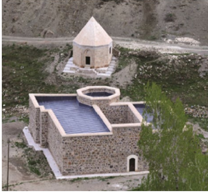
Şekil 25. Evliya Bey Medresesi onarım sonrası
