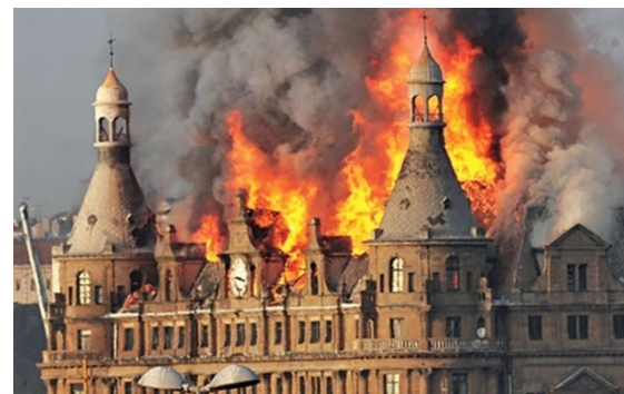
Şekil 7 a. Haydarpaşa Gar binasında yangın
