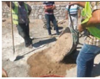
b. Elle karıştırılması (Yardımlı, Işık, ve Balık, 2018)
