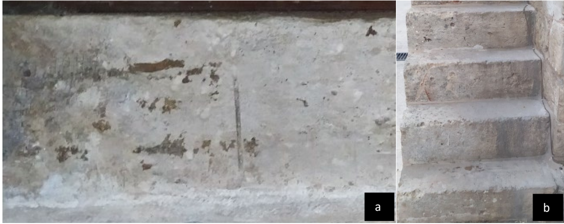
Şekil 16. Aşınma oluşumundan kaynaklı bozunmalar
