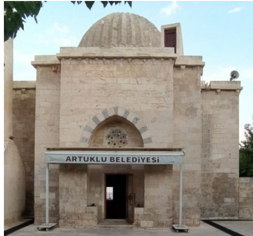
Şekil 7. Sultan Hamza-i Kebir Camii'nin kuzey cephesi
