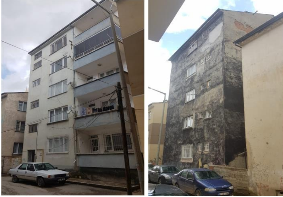
Şekil 1. Ön ve Arka cephe Görünümü
