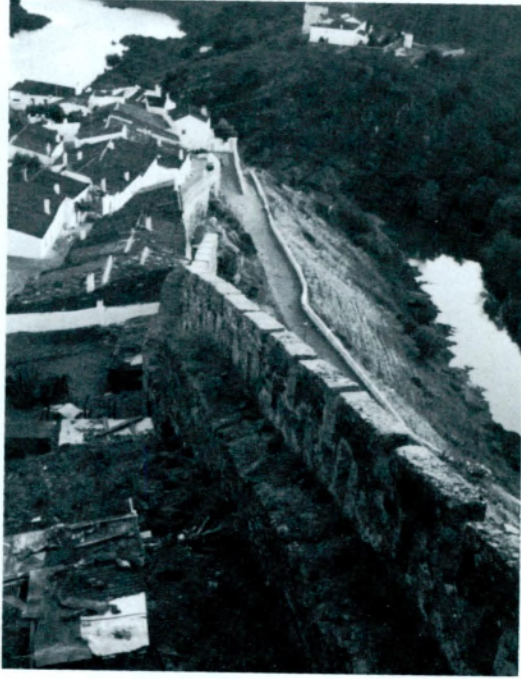
Res. 11 — İç kaleden Mertola surlarının ve surlar üzerindeki siperlerin görünümü.
