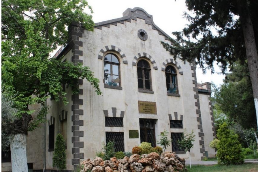
Şekil 10: Andrews Hall Doğu (Giriş) Cephesi
