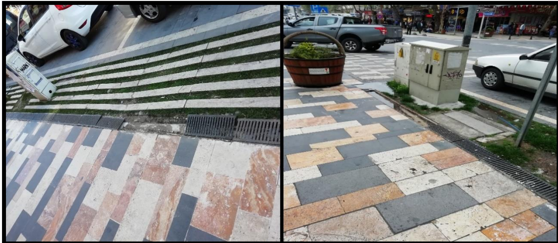
Şekil 9. Trabzon Bulvarı Su Tahliye Sistemi (Zabun, 2019)
