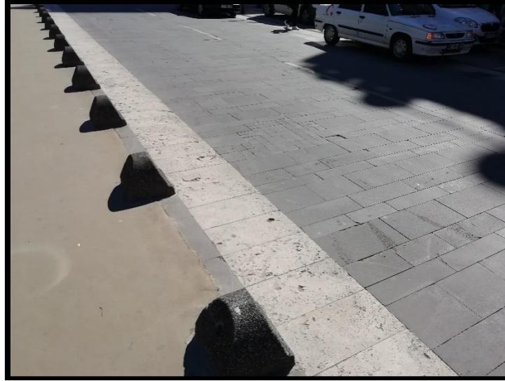
Şekil 3. Trabzon Bulvarı Araç Yolu Döşemesi
