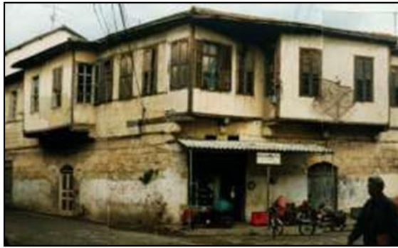
Şekil 6: Solda, Kızılmurat mahallesi, 42 Sokak, 4 no.lu evin pencere kepenkleri, iki kanatlı sağır kapaklardan oluşur. Kepekler düşey ekseninde hareket ederek sokağa görüş sağlanmakta ve gün ışığı iç mekâna kontrollü bir şekilde girmektedir. Pencere ile kepenk arası yatay ekseninde demir parmaklı düzenlenmiştir. Sağda, Caminur Mahallesi 0805 Sokakta yer alan ahşap kepenk (Kişisel arşiv, 1998).
