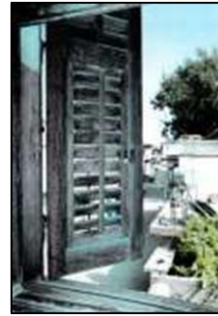
Şekil 6: Solda, Kızılmurat mahallesi, 42 Sokak, 4 no.lu evin pencere kepenkleri, iki kanatlı sağır kapaklardan oluşur. Kepekler düşey ekseninde hareket ederek sokağa görüş sağlanmakta ve gün ışığı iç mekâna kontrollü bir şekilde girmektedir. Pencere ile kepenk arası yatay ekseninde demir parmaklı düzenlenmiştir. Sağda, Caminur Mahallesi 0805 Sokakta yer alan ahşap kepenk (Kişisel arşiv, 1998).
