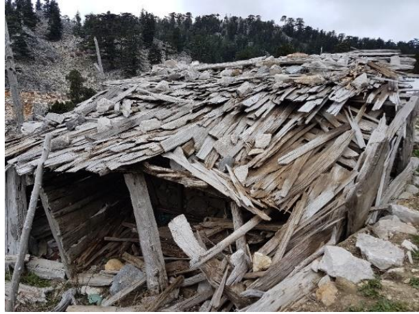
Şekil 13. Salamat Yaylası’nda bir obanın yongalı çatısı (Akkaya, 2019)
