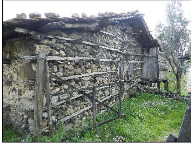
Şekil 4. Düğmeli yapı örneği (Akkaya, 2019)
