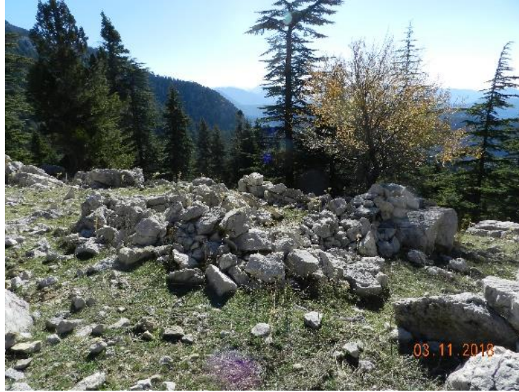
Şekil 15. Çataloluk mevkinde yer alan metruk yapı
