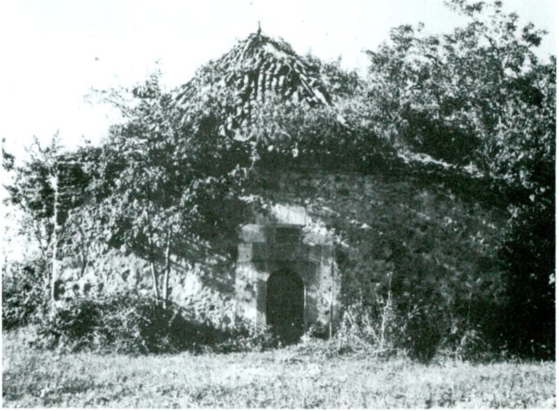
Res. 15 — Bafra, Türbe Köyü Emir Mirza Türbesi
