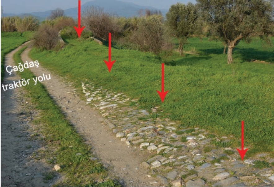
Fot. 13: Hüseyin Ağa Köprüsü'ne varan döşeme yol kalıntıları. (Bk. Şek. 1 - III). (2018, E.Özbay)
