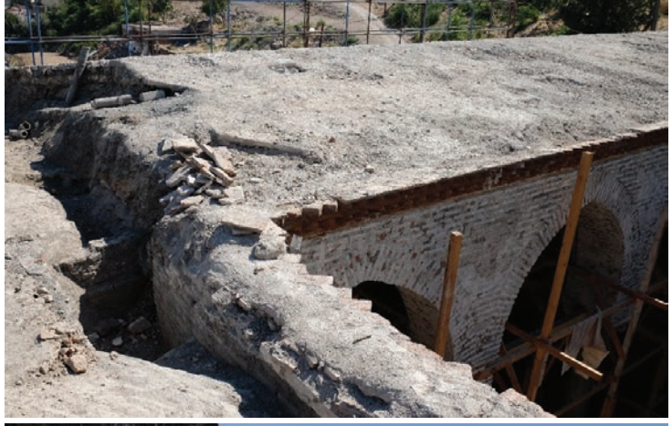
Fotoğraf 30- Avlu kuzeydoğusundaki kazı ve temizlik çalışmaları.
