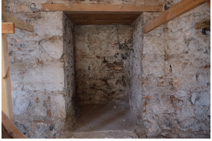
Fotoğraf 20- Avlu doğu duvarının kuzeyindeki niş.
