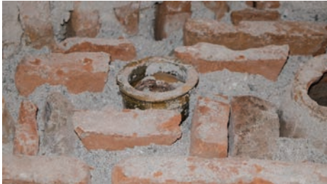
Fot. 15-16: Harimin kuzey duvarı üzerinde yer alan ve ağız kısmı dışa bakan testiler (Fotoğraf: C.Gürbıyk).
