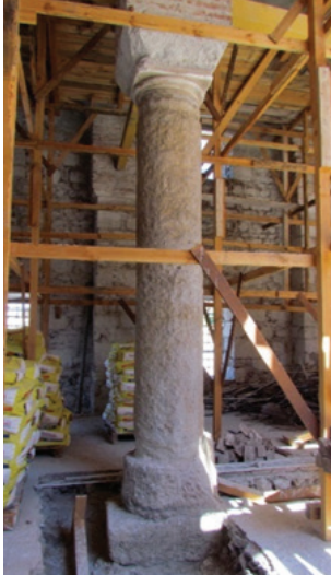
Fot. 23: Sütun altına yerleştirilmiş andezit kesmetaş blok
