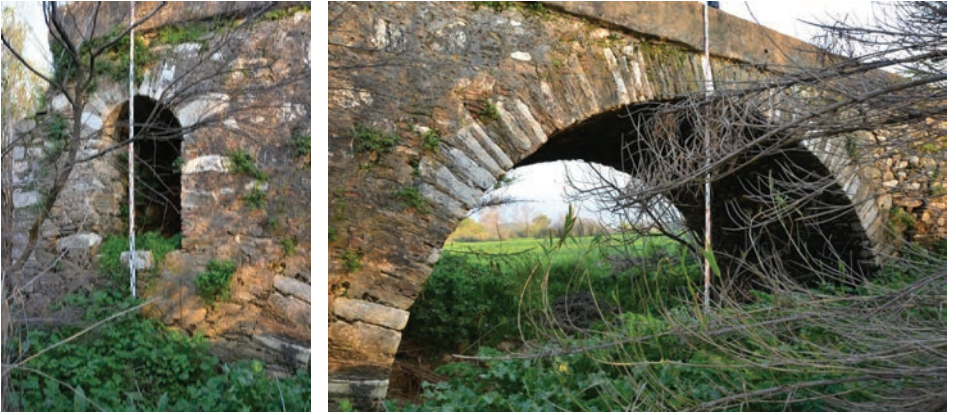
Fot. 3: Hüseyin Ağa Köprüsü; güney yakadaki kalıntılarda ayak bünyesindeki hafifletme gözü (Şek. 2'de A1 ) ve güneyindeki büyük göz (Şek. 2'de G2 ). Mansap cephesi. (2018, E.Özbay)
