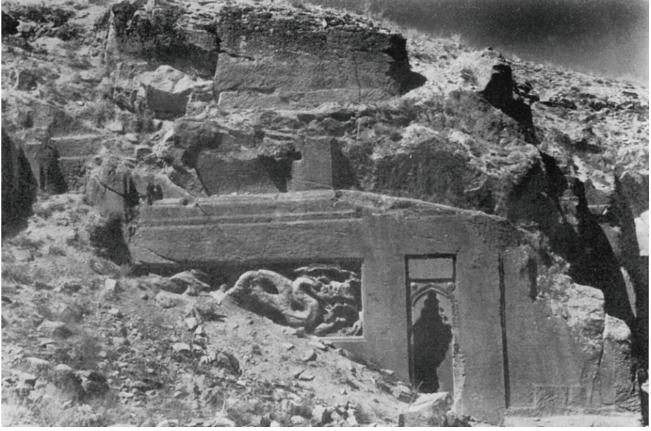
Fot. 3: Taşkesen, batı cephe ve iç mekânın 1970'li yıllardaki görünümü (Scarcia, 1975, Fi.10)
