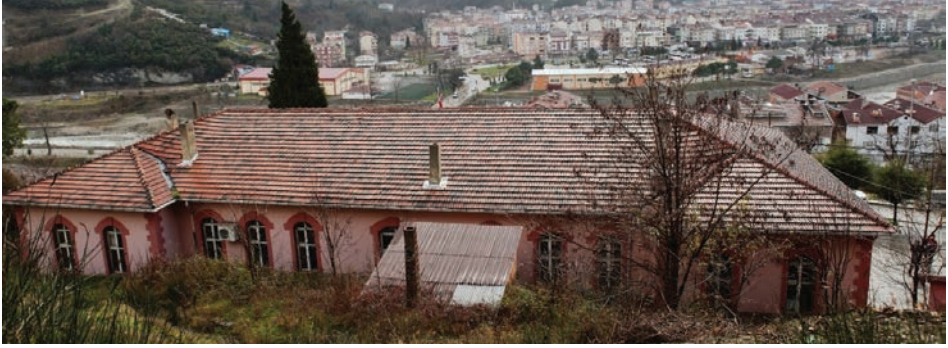
Fot. 3: Mehmet Akif Ersoy Ortaokulu Kuzey Cephesi
