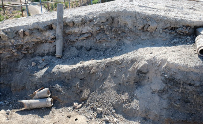
Fotoğraf 33- Avlu kuzeydoğusundaki kazı ve temizlik çalışmaları.
