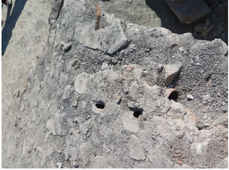
Fot. 3: Manisa Ulu Cami avlusunun kuzeydoğu revakının örtü sisteminde kullanılan testiler (Fotoğraf: S. Gök).
