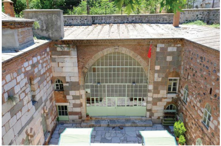
Fotoğraf 14- Medrese. Onarım öncesi avlu güney kanadı.
