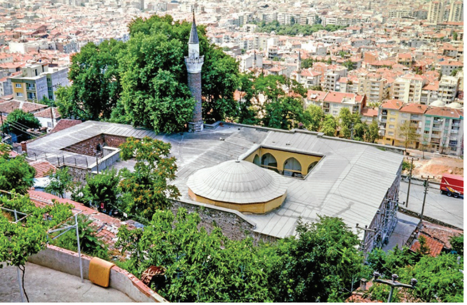
Fotoğraf 28- Onarım öncesi yapının betonarme örtüsü.
