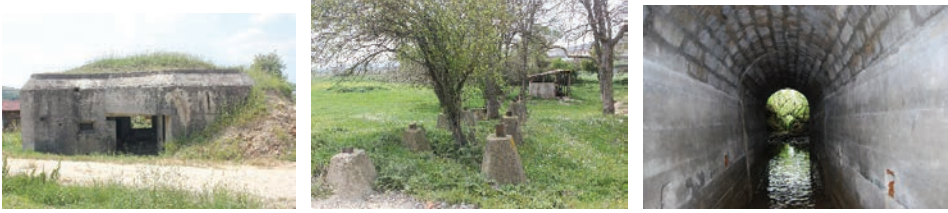
Şekil 37: Çakmak Hattı'na ait bir korugan, tank mani hattı ve yeraltı tüneli (Yazar, 2020).
