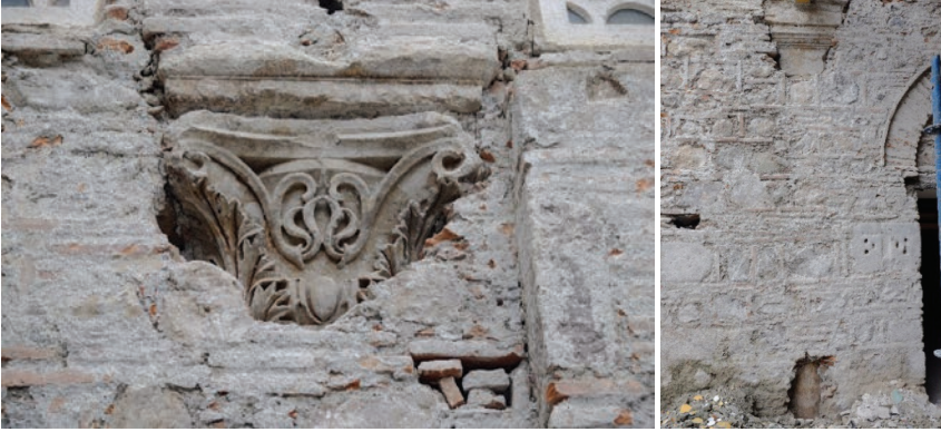
Fotoğraf 24- Duvar içerisinde kalan sütunlar.
