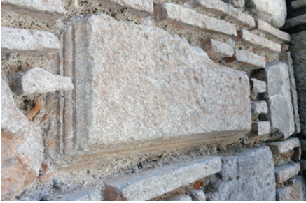
Fot. 28: Duvar inşa malzemesi olarak kullanılmış mimari eleman
