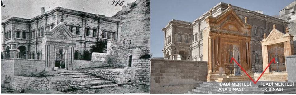
Görsel 3: 1900lü yıllarda ana bina anıtsal kapısı ve 1932 yılında inşa edilen ek binadan sonra ortak avluya erişim sağlayan anıtsal kapılar (Kaynak: Şanlıurfa KVK Bölge Kurulu Arşivi)
