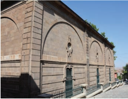
Fot.16: Güney cephesi.
