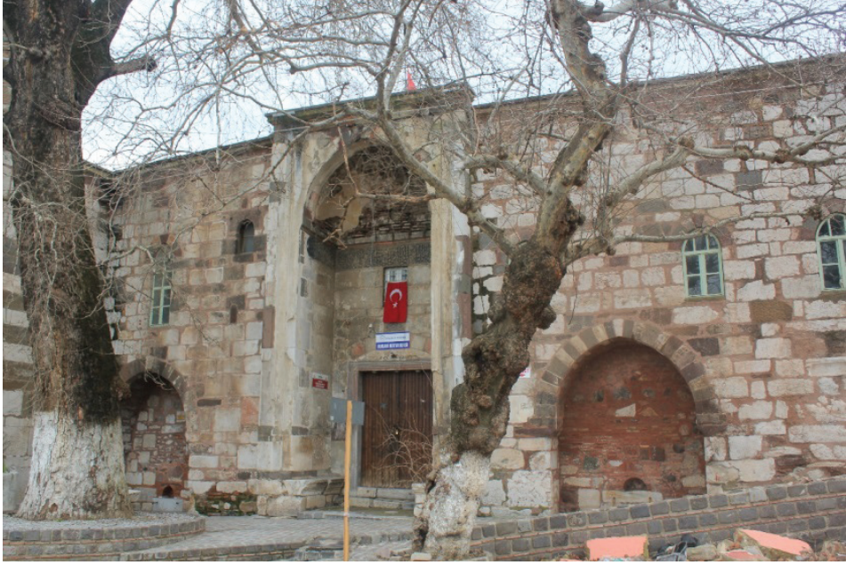
Fotoğraf 12- Medrese kuzey cephesi.
