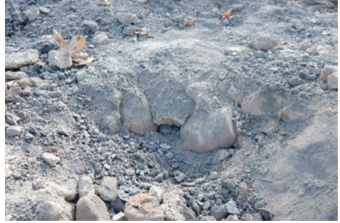
Fot. 4, 5: Manisa Ulu Cami avlusunun kuzeydoğu revakının örtü sisteminde kullanılan testiler (Fotoğraf: C. Gürbıyık).
