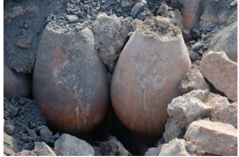
Fot. 6, 7: Manisa Ulu Cami avlusunun kuzeydoğu revakının örtü sisteminde kullanılan testiler (Fotoğraf: C. Gürbıyık).
