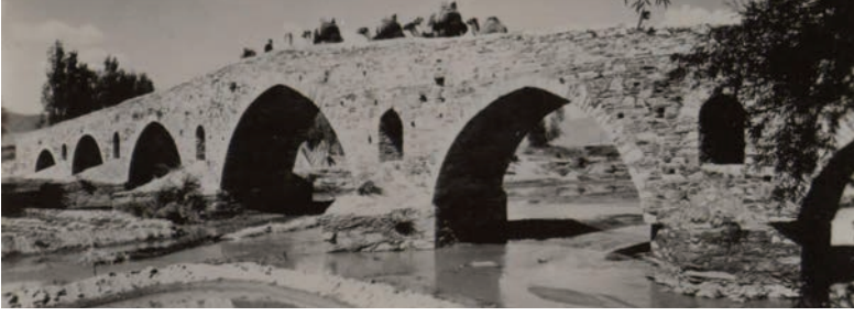
Fot. 10: Hüseyin Ağa Köprüsü, mansap cephesi; ~1930'lu yıllar. Aslından detay. 43
