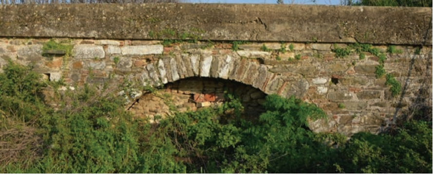
Fot. 2: Hüseyin Ağa Köprüsü, güney yakadaki kalıntılarda uzun yığma duvar bölümü ortasındaki göz. Mansap cephesi. (Şek. 2'de G1 ) (2018, E.Özbay)
