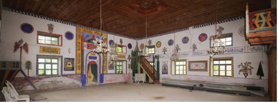
Görsel 12: Güney ve Batı Duvarı Genel Görünüşü
