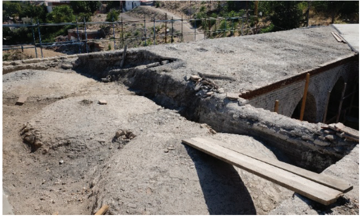
Fotoğraf 32- Avlu kuzeydoğusundaki kazı ve temizlik çalışmaları.
