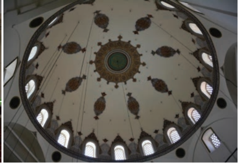
Fot.8: Yapının merkezi kubbesi.
