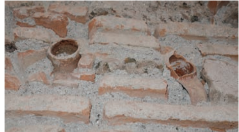
Fot. 15-16: Harimin kuzey duvarı üzerinde yer alan ve ağız kısmı dışa bakan testiler (Fotoğraf: C.Gürbıyk).
