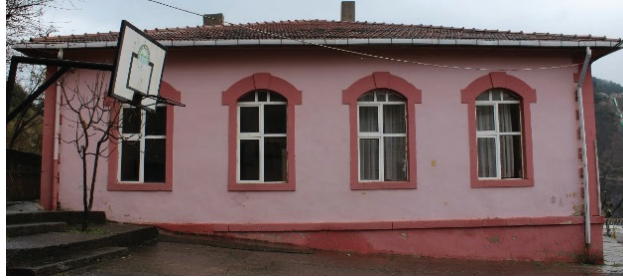
Fot. 2: Mehmet Akif Ersoy Ortaokulu Batı Cephesi
