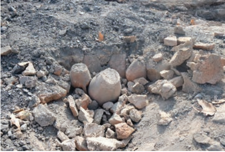
Fot. 6, 7: Manisa Ulu Cami avlusunun kuzeydoğu revakının örtü sisteminde kullanılan testiler (Fotoğraf: C. Gürbıyık).
