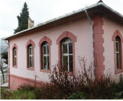
Fot. 4: Mehmet Akif Ersoy Ortaokulu Doğu Cephesi
