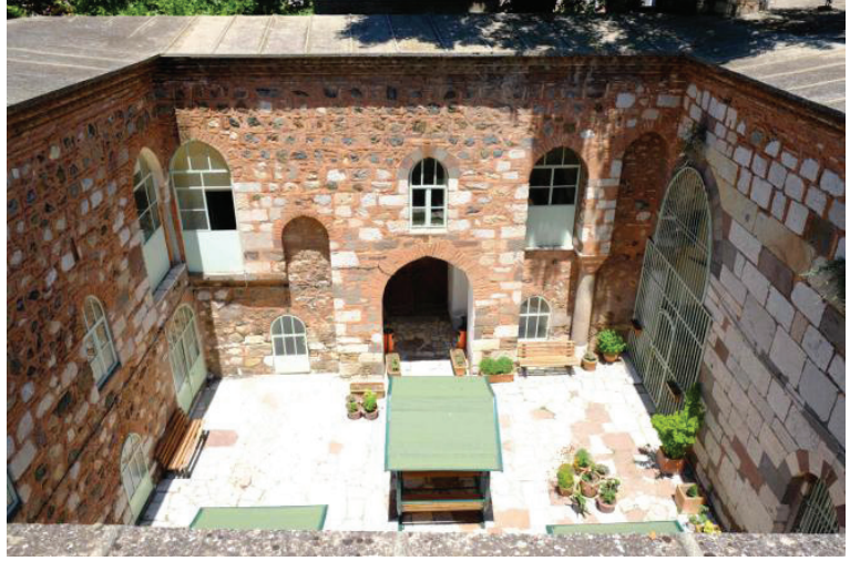
Fot. 13- Medrese. Onarım öncesi avlu kuzey kanadı.
