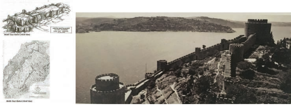
Sekil 4: Solda, Melik Gazi Kalesi, Kayseri (Karpuz, 2004). Sağda, Rumeli Hisarı, İstanbul (Couto, 2016).
