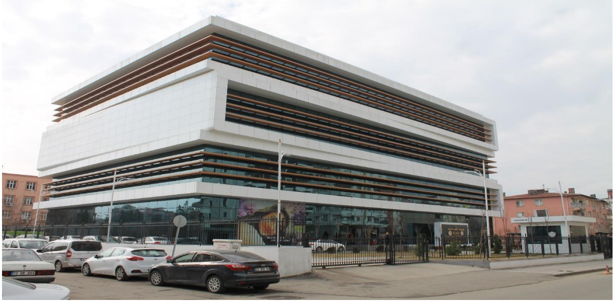
Görsel 1. Batman Şehit Şenay Aybüke Yalçın İl Halk Kütüphanesi'nin dış cephe görünüşü
