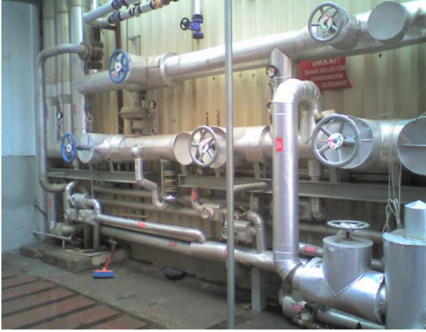
Şekil 4. Buhar dağıtım sistemi
