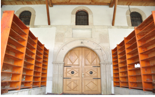
Fotoğraf 1. 2016-2018 TİKA Restorasyonundan Önce Kapının Üzerindeki Boş Kitabelik Bölümü
