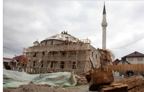
Fotoğraf 7. 2016-2018 TİKA Restorasyonunda Caminin Kubbесinin Yenilenmesi
