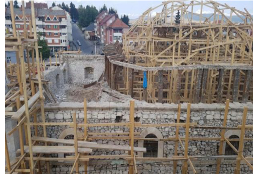
Fotoğraf 7. 2016-2018 TİKA Restorasyonunda Caminin Kubbесinin Yenilenmesi
