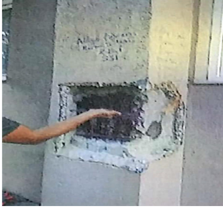
Şekil 7. Zemin kat Kolon sıyırma
