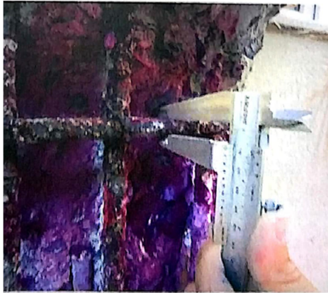
Şekil 8. Zemin kat Kolonu enine donatı tespiti
