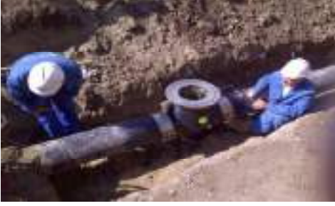
Şekil 3. Redüksiyonlu Güçlendirilmiş Branşman [url-3].
