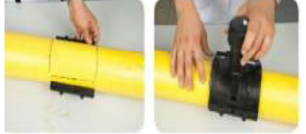
Şekil 5. Ayrık T-bağlantı ile yapılan branşman [url-5].
