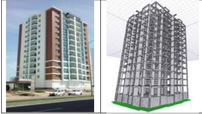
Şekil 3:(a) Bina genel görünümü, (b) Binanın üç boyutlu modellemesi
