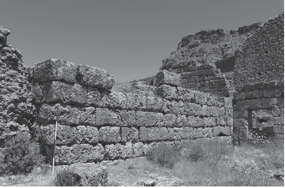
Fig. 13 Yapının Bosajlı Duvarının Detayı ve İkinci Evrede Eklenen IV nolu Salon'unun III nolu Salon'la Birleşen Bölümü.
