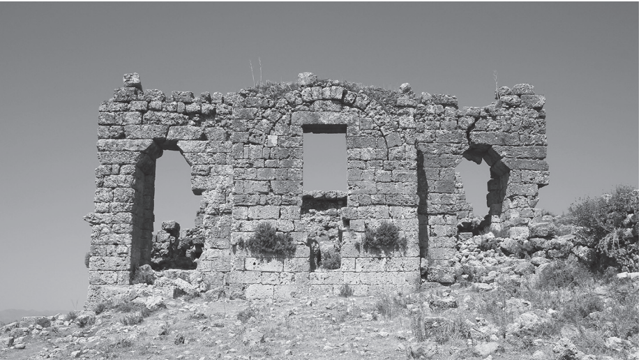
Fig. 14 Hamamın güney cephesi.
