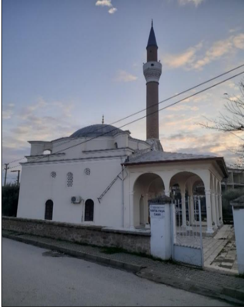
Resim-I /Yahya Paşa Cami Genel Görünüm
