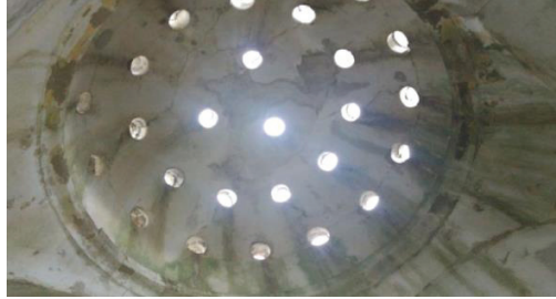
Resim 13. Trabzon askeri hamamının sıcaklık kubbesi (XIX. yüzyıl) (Uçar 2020:119).
