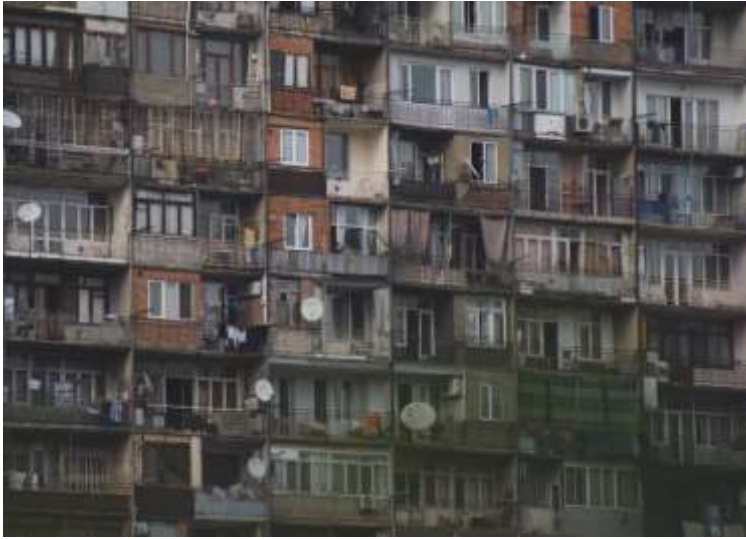
Görsel 6: Cephesi Eklemelerle Deformasyona Uğramış Bir Yapı (Tchokhonelidze, 2020).
