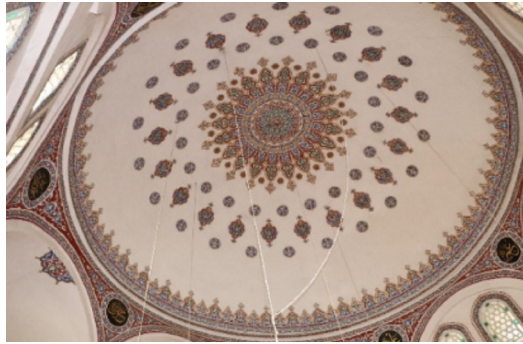
Resim 9: Seferağa Camii kubbe ve kubbeye geçiş bölgesi
