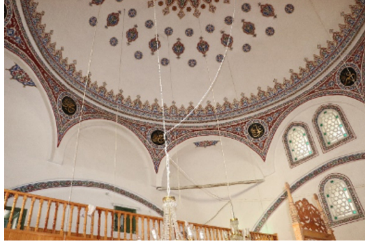
Resim 8: Seferağa Camii kubbe ve kubbeye geçiş bölgesi
