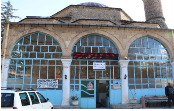
Resim 22: Seferaga Camii son cemaat yeri ve camiye giriş kapısı.
