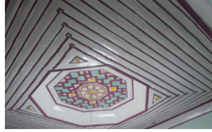
Fotoğraf 12: Merkez Kuloğlu Camii harim tavanından genel görünüm
