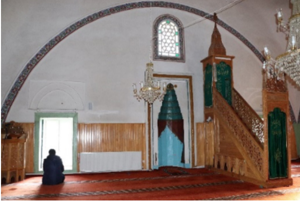
Resim 28: Seferağa Camii iç mekânda duvar yüzeyindeki friz kuşağı
