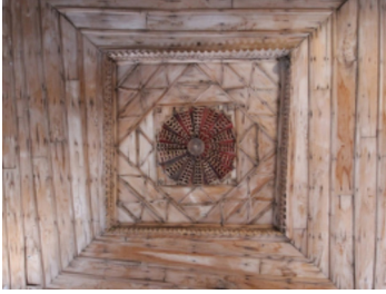
Fotoğraf 13: Boyacık Mahallesi Eski Camii harim tavan göbeğinden genel görünüm
