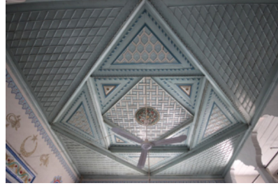
Fotoğraf 10: Esenyurt Mahallesi Camii harim tavanından genel görünüm
