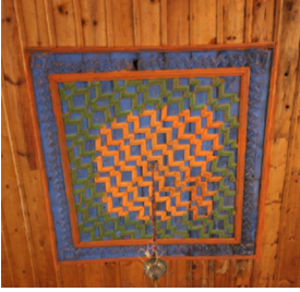
Fotoğraf 5: Köylüce Mahallesi Camii tavan göbeğinden genel görünüm
