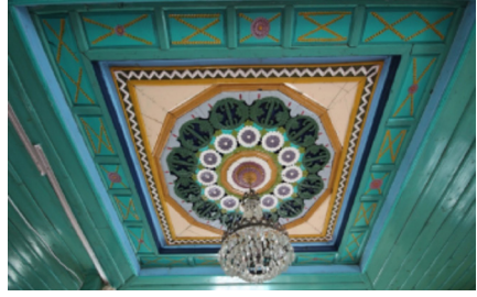
Fotoğraf 4: Üşümüş Mahallesi Camii kadınlar mahfili tavanından genel görünüm
