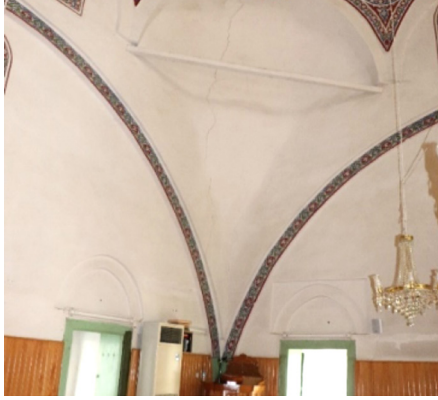
Resim 29: Seferağa Camii iç mekânda duvar yüzeyindeki friz kuşağı
