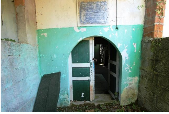
Res. 8: Kuzeybatı Cephe, Camiye Geçiş Kapısı
