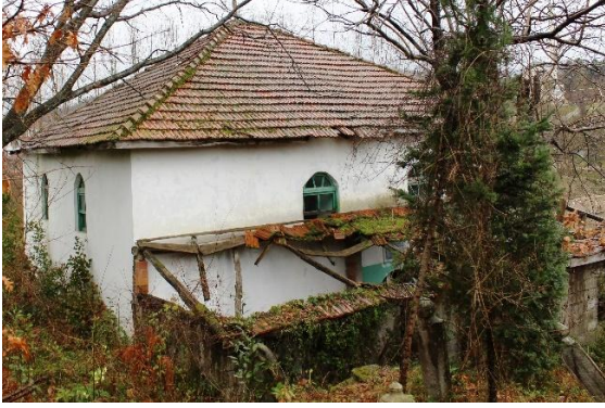
Res. 4: Caminin Kuzeyden Görünümü
