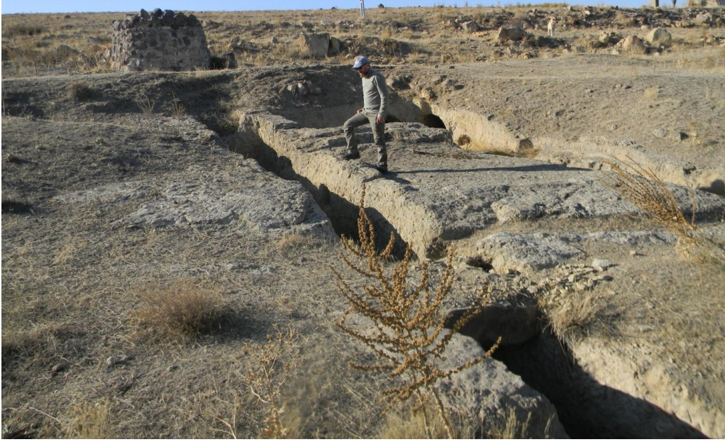
Resim 2: Hacı Ahmedin (Keler) Değirmeni önde çark açık kanalı, yanda değirmen ağzı, üstte kapalı oluğu.
