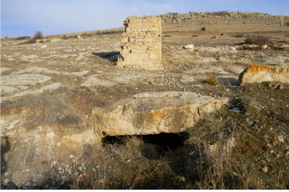
Resim 11: Keler Değirmeni önde giriş açıklığı devamında kapalı oluğu görünüşü.
