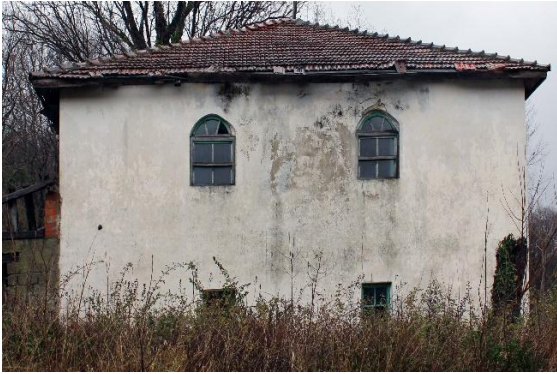
Res. 6: Güneybatı Cephe
