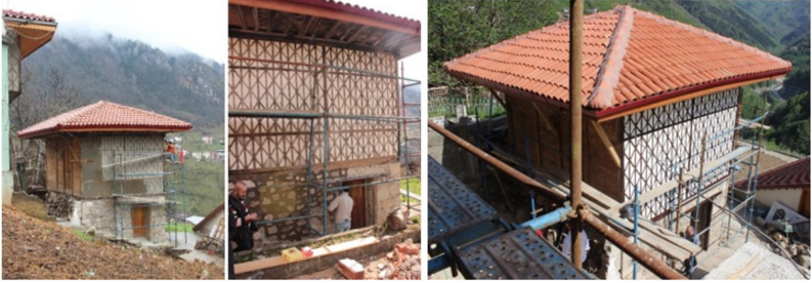
Resim 32. Medresenin cephelerinde yapılan imalatlar.
