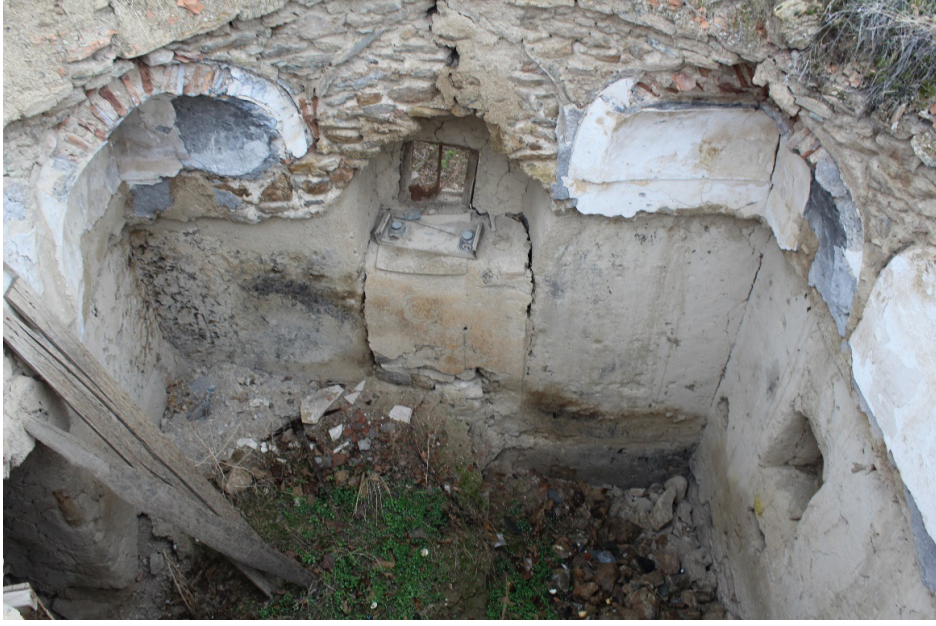
Fotoğraf 7. Elazığ Keban Yusuf Ziya Paşa Konak Hamamının İç Doğu Duvarı
