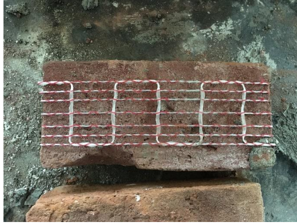
Şekil 1. Çalışmada kullanılan Murfor® yatay derz donatısının tatbiki.
