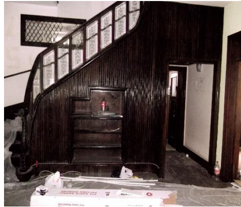
Camlı korkuluk detayı Merdivenin orta holden görünümü Baba dikmesi Şekil 4. İbrahim Cumalı Evi'nin iç mekân merdiven ayrıntısı (Hatice Uçar arşivinden)
