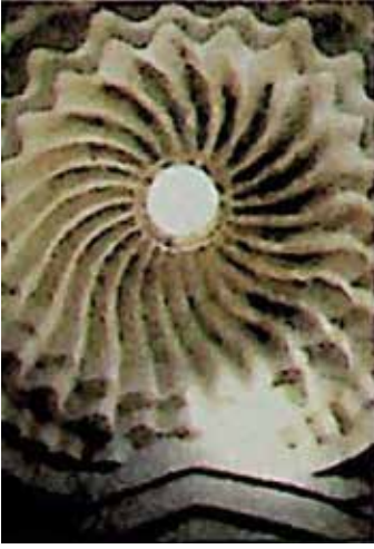
Figure 12a: Bursa Emir Sultan Hamamı Kubbe Süslemesi (Şehitoğlu, 2008, s. 56)
