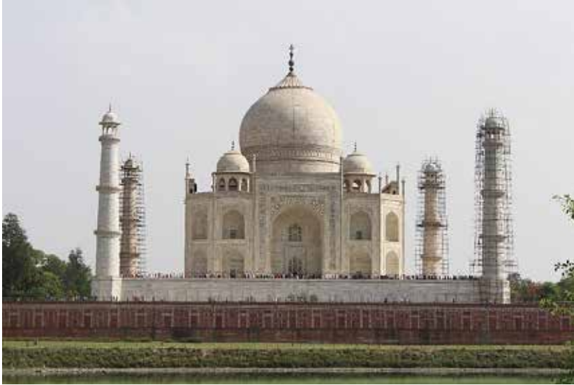
Fotoğraf 6: Tac Mahal Türbesi'nin Mehtab Bağından Genel Görünüşü (Özler, 2016)
