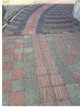
Şekil 31. Birbirini karşılamayan hissedilebilir yüzey
