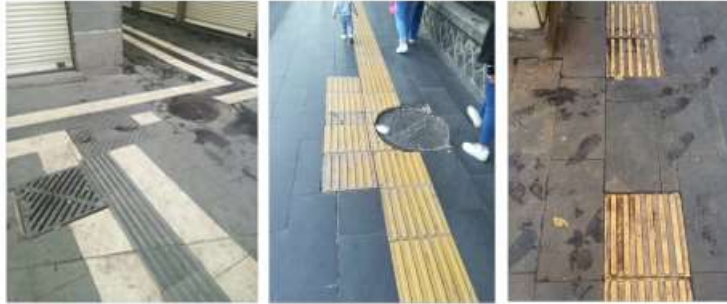
Şekil 20. Kesintiye uğrayan hissedilebilir yüzeyler
