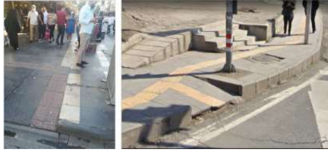
Şekil 14. Kaldırım rampasındaki düzenlemeler
