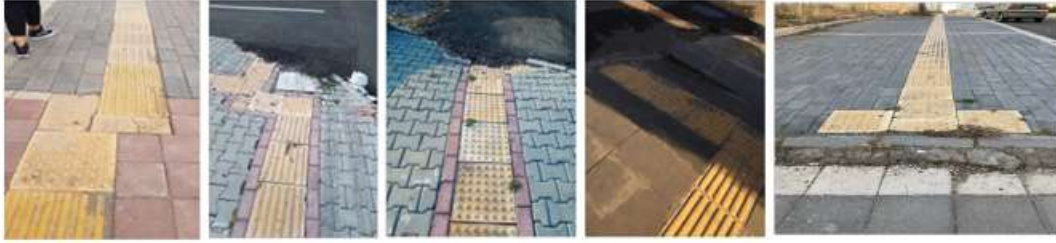
Şekil 19. Yanlış düzenlenen uyarıcı yüzeyler
