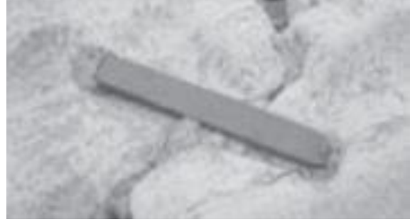
Resim 5. Üsküdar meydan cami duvarı kenet bağlantı sistemi (Kurugöl-Küçük, 2015: 526).
