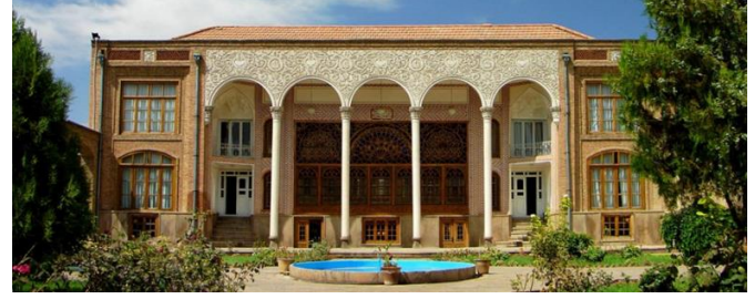
Şekil 6. Behnam Konutunun giriş cephesi ( https://tinyurl.com/y3ccpaj7 )
