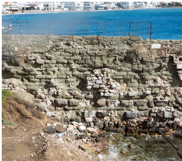
Şekil.21-1, 2, 3: Geçmiş dönem uygulaması olan çimento bağlayıcılı harç kullanılarak yapılan moloz dolgu örnekleri
