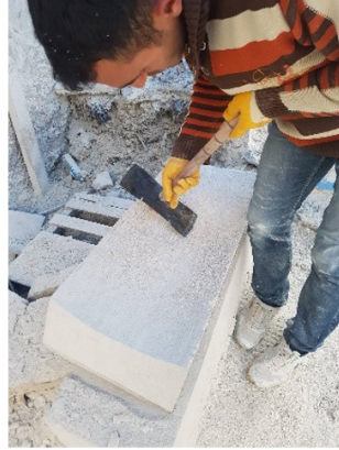
Şekil 16: Yeniden kullanılamayacak durumda olan yapı elemanlarını aslına uygun olarak yenilenmesi
