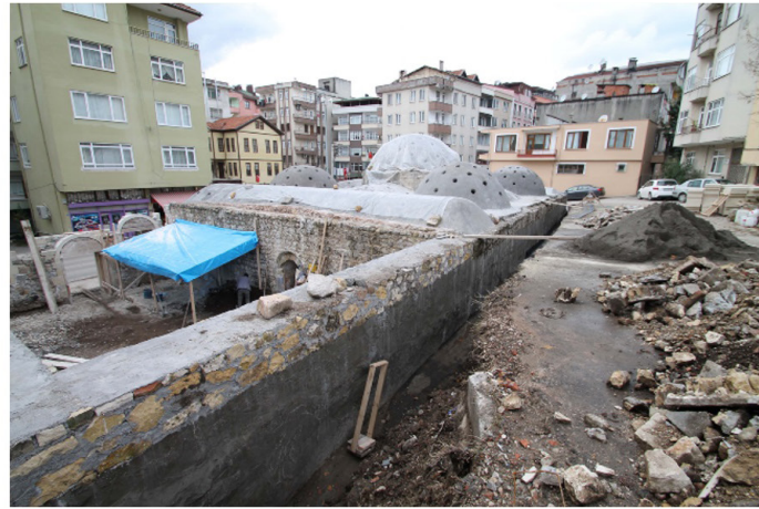
Şekil 17: Bütünleme, eksik parçaların ve elemanların aslına uygun olarak tamamlanması
