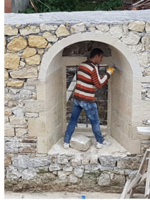
Şekil 16: Yeniden kullanılamayacak durumda olan yapı elemanlarını aslına uygun olarak yenilenmesi
