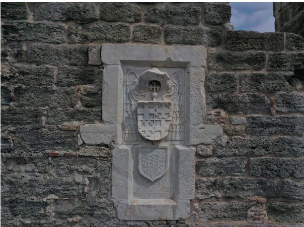
Şekil.8-1, 2, 3: Mermer taş ve devşirme mermer malzeme kullanımı
