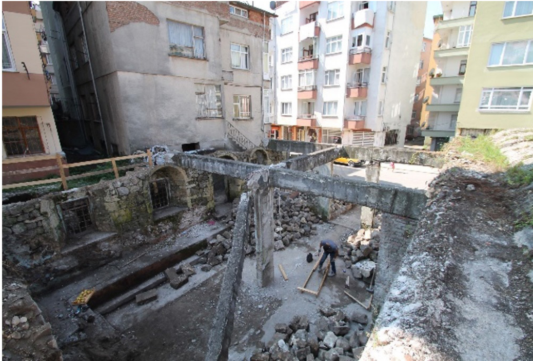
Şekil 14: Yapıya sonradan eklenmiş olan nitelsiz muhdes eklerin kaldırılması
