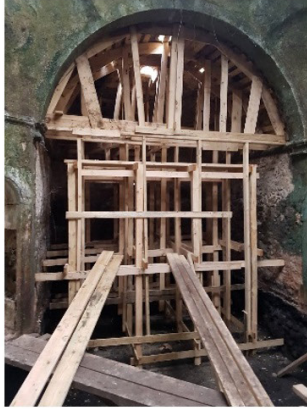
Şekil 16: Yeniden kullanılamayacak durumda olan yapı elemanlarını aslına uygun olarak yenilenmesi
