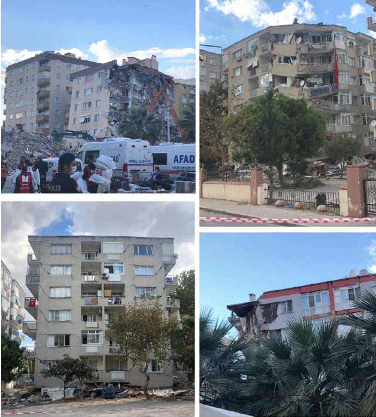
Şekil 2: Bornova Ovası'nda deprem sırasında ağır hasar alan binalardan fotoğraflar. Figure 2: Pictures of some of the buildings got damaged during Samos Earthquake.
