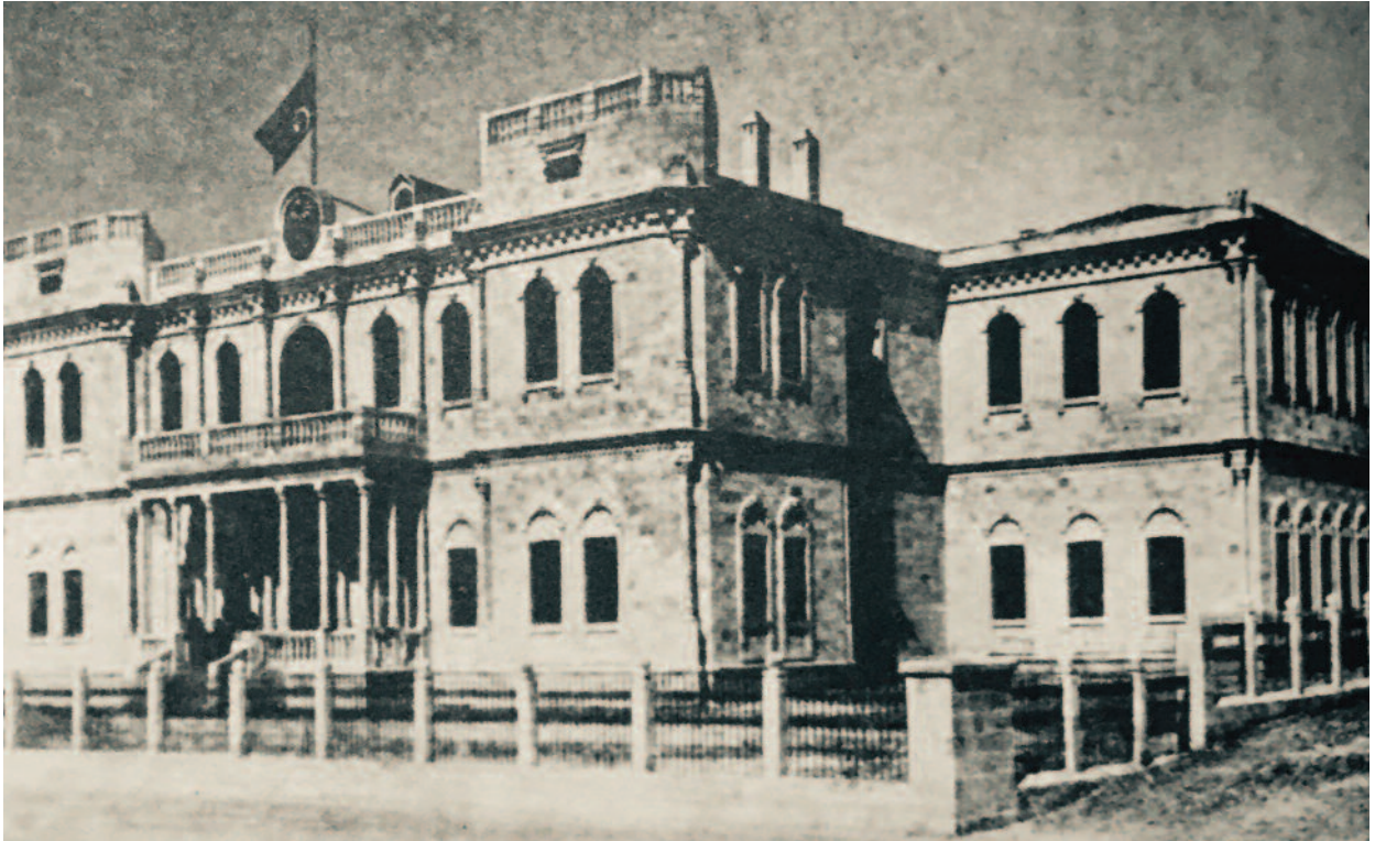
Urfa Hamidiye Hastanesi de olarak anılan binanın inşaatı 11 ayda tamamlanmıştır.
