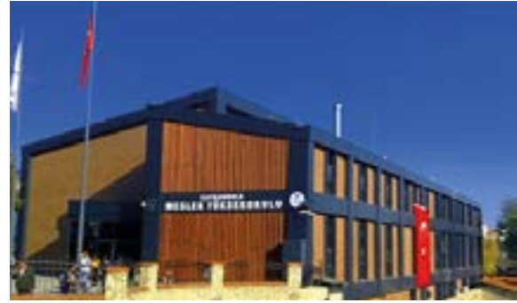
Şekil 5. SMYO Binası Genel Görünüm
