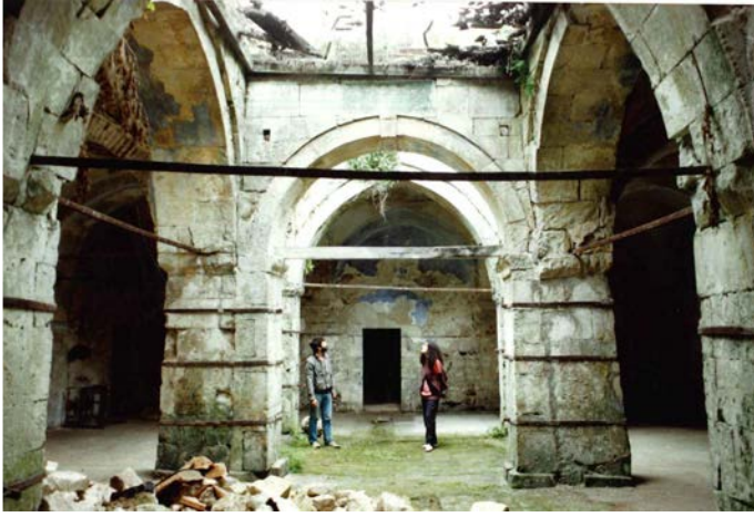
Bahçesaray'da Zincirli Medrese'nin tamir olmadan önceki durumu. Foto: Zafer Karatay
