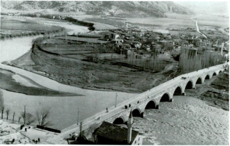
Res. 4 — Osmancık Koyunbaba Köprüsü
