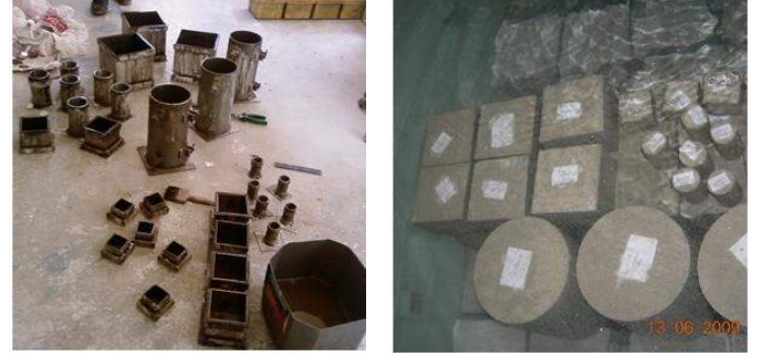
Şekil 2.2 Betonun Kalıba Yerleştirilmesi ve Kürü
