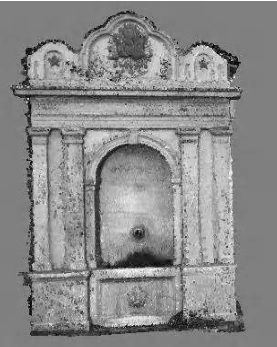
Şekil 3. Hürriyet Çeşmesi'nin 3B yoğun nokta bulutu.
