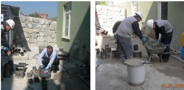
Şekil 2.1.Şantiyede Beton Küp Numune Alma
