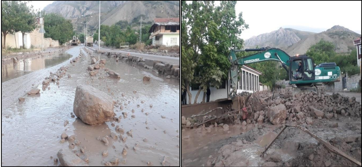
Fotoğraf 1: 13 Temmuz 2020'de Erzincan'da etkili olan sağanak yağış sonrası meydana gelen sel Yaylabası birikinti yelpazesi üzerinde bulunan menfezlerin tıkanmasına ve menfezden anayola taş ve rusubat taşmasına neden olmuştur.
