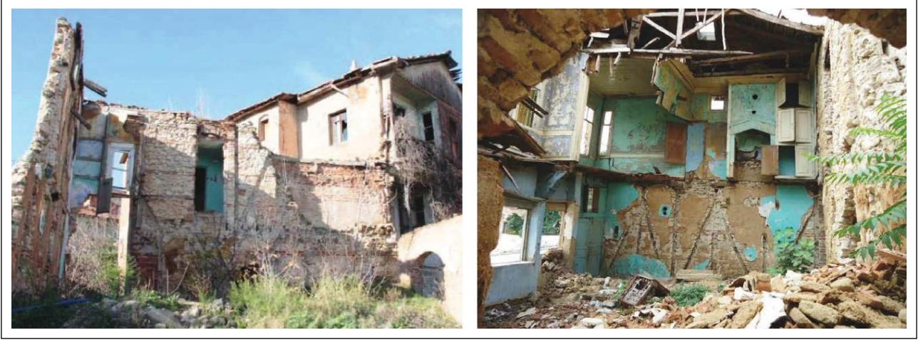
Şekil 10. Tuna Soykan Evi ve Yayla Mahallesi'nde yer alan bir yapıya ait kâgir sistemini gösteren fotoğraflar (Deniz, 2016, 155, 167).
