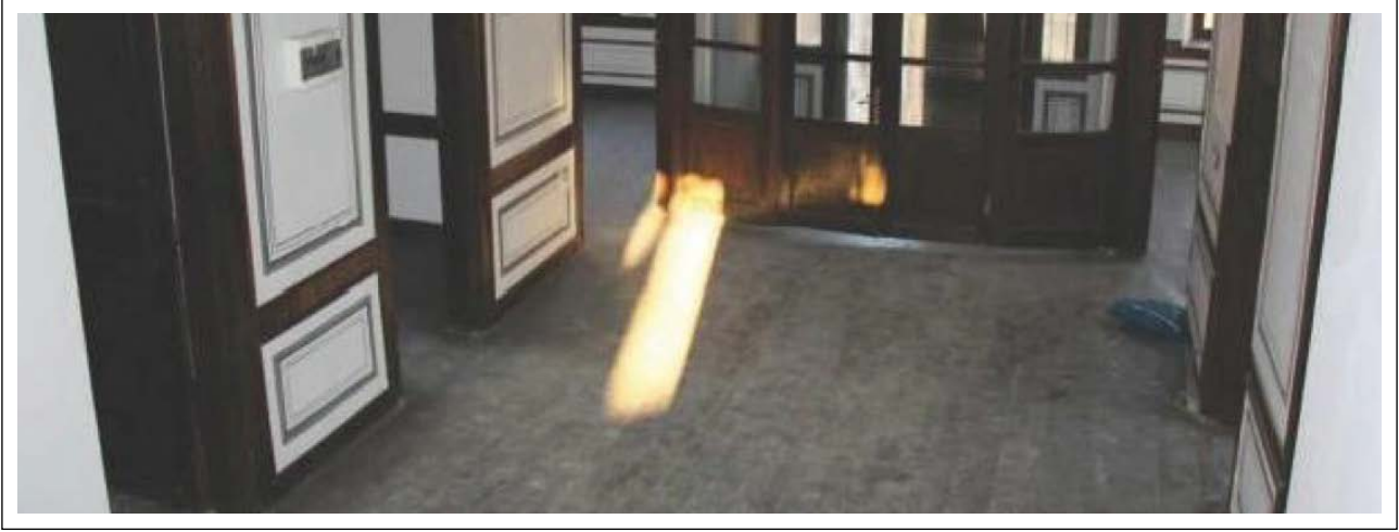
Şekil 13. Türk Ocağı Binası zemin kat sofası ahşap döşemeleri (Deniz, 2016, 122).
