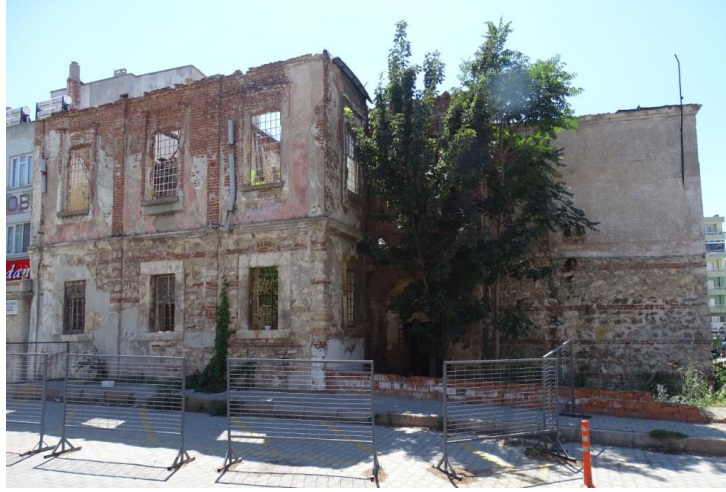
Resim 2: Kuzey cephe, genel görünüş
