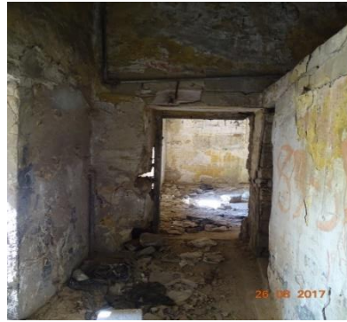
Resim 13: Hol'den batı yönünde yer alan koğuşa geçilen giriş
