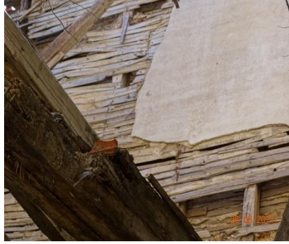
Resim 3: Bağdadi teknikte yapılmış ara duvarlar
