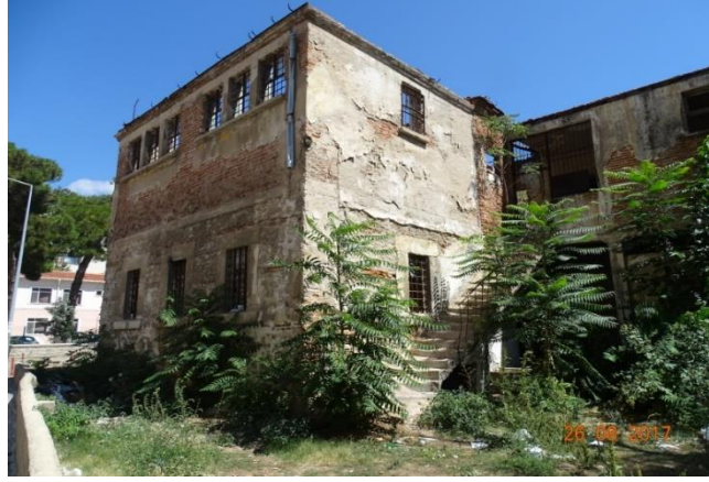
Resim 34: Batı cephesi, köşe
