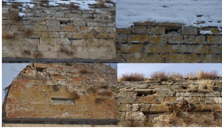
Fotoğraf 4. Üst örtü birim malzeme kayıpları
