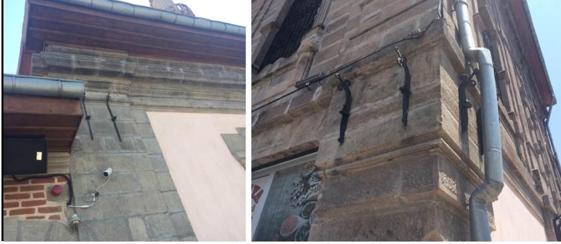
Resim 22: Taşıyıcı sistemde kullanılan demir kılıçlar (Yazarın arşivi, 2019).
