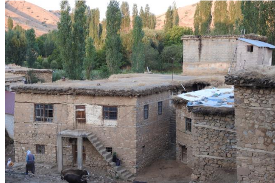
Şekil-4: Bitlis Yolalan Köyü'nden düz toprak damlı evler (Ergün Şimşek'in kişisel arşivi, 2019)
