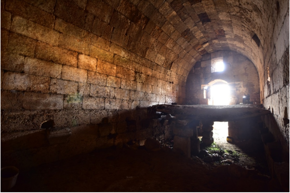
Fot. 18. Kuzeydeki bölümden batıya bakış
