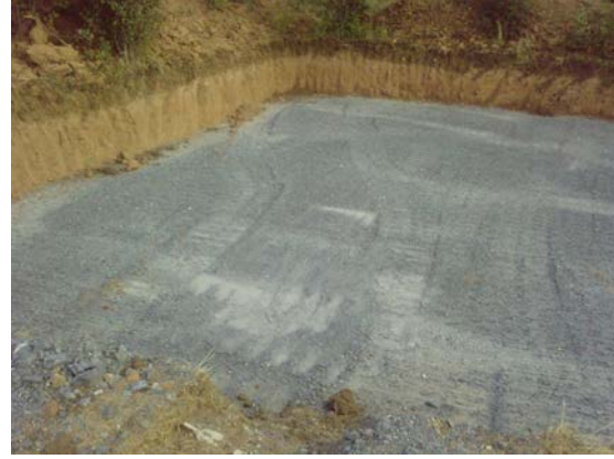
Fotoğraf 4: Temel inşaatı öncesi zemin (Hülya Soydaş Çakır, 2009)
