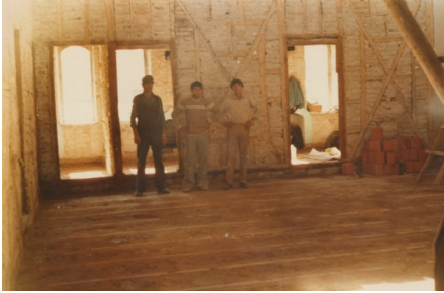
Resim 23: Medrese bölümü ahşap karkas iç duvarlar (VGMA,2013).
