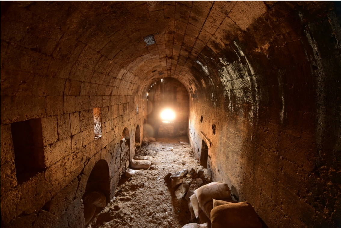
Fot. 16. Nartekse güneyden bakış (Fot. Tehsin BARAVİ).
