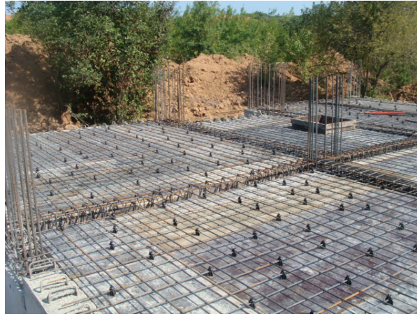
Fotoğraf 5: Zemin kat döşemesi betonarme imalatı (Hülya Soydaş Çakır, 2009)
