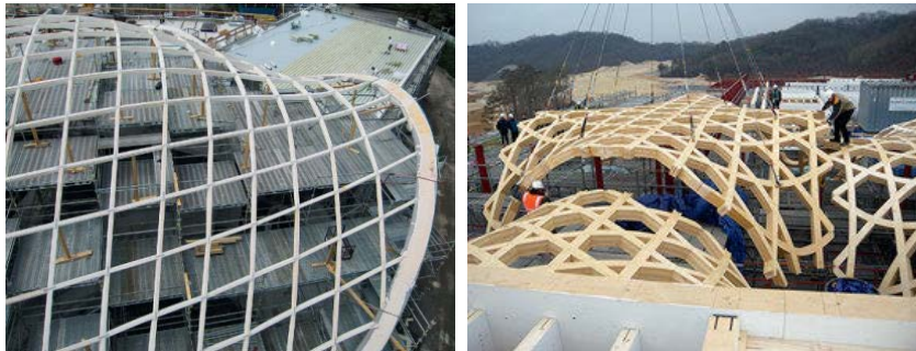
Şekil 14. Rijit ahşap izgara kabukların montajı; Toskana Thermal Bad Orb, Haesley Nine Bridges (Jeska, Hascher ve Pascha, 2014, s. 116-165).
