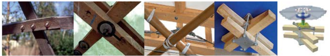
Şekil 12. Earth Center, Multihalle Mannheim, Weald and Downland, The Japan Pavilion, The Chiddingstone yapılarındaki düğüm noktaları (Chilton ve Tang, 2016, s. 32-46; Naicu vd., 2014; Url-1).
