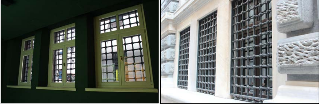
Şekil 7: Osmanlı Bankası Müzesi iç mekânda ve yapı cephesinde pencereler (Yazar Kişisel Fotoğraf Arşivi).
