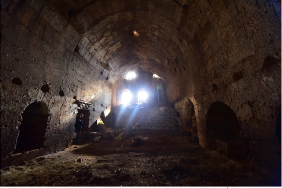
Fot. 11. Naosun güney cephesine bakış (Fot. Tehsin BARAVİ).
