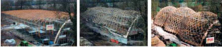
Şekil 9. Kademeli aşağıya indirme yöntemi; Weald and Downland ızgara kabuğu (Harris, Kelly, ve Dickson, 2003, s. 32).
