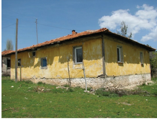
Fotoğraf 3. Yeşilova Köyü, 2 Nolu Oda, Genel Görünüş
