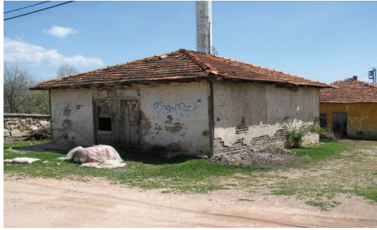
Fotoğraf 2. Yeşilova Köyü, 1 Nolu Oda, Genel Görünüş
