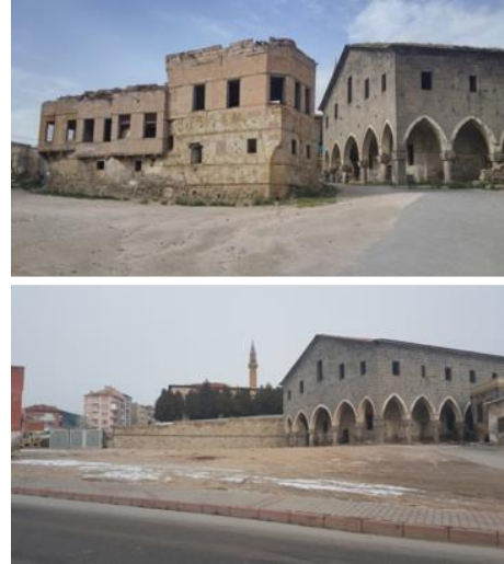
Resim 8. Üstte 2016 yılında harap Rum Kilisesi ve yakınındaki geleneksel konutlar, altta 2019 yılında onarılan Rum Kilisesi ve yok edilen geleneksel konutlar
