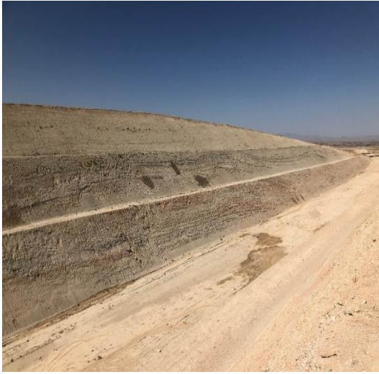
Şekil 8. Km: 217+600 kesitinde güney (sağ) şevler
