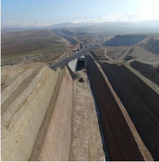
Şekil 16. Km: 218-500- 219+00 civarı şev çalışma bölgesi ve aç kapa sanat yapısı görüntüsü
