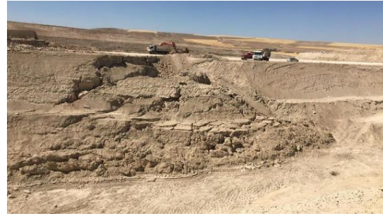
Şekil 7. Çalışma alanında izlenen dairesel kayma örnekleri
