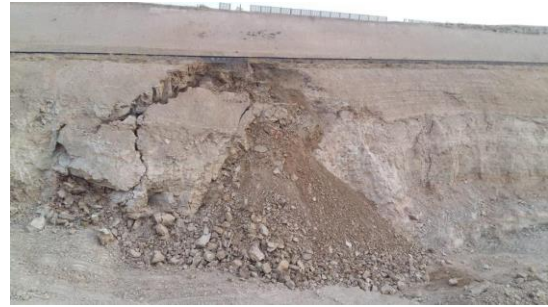
Şekil 6. Çalışma alanında izlenen dairesel kayma örnekleri
