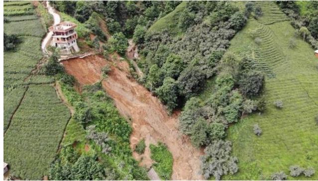
Şekil-21: Yağışlar Nedeniyle Oluşan Heyelan
