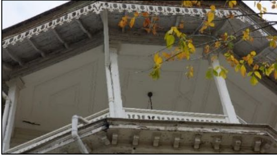
Şekil 19. Balkon ahşaplarında bozulmalar (Kaya, 2021) Şekil 20. Islak zeminlerde bozulmalar (Kaya, 2021)
