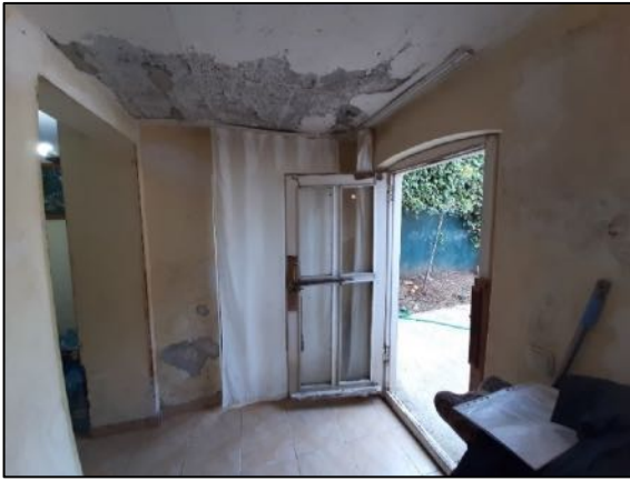
Şekil 21. Bodrum tavanlarında bozulmalar (Kaya, 2021) Şekil 22. Duvarlarda bozulmalar (Kaya, 2021)
