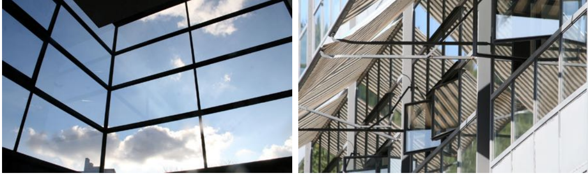
Şekil 5. Fagus Fabrika Binası, Kolonsuz Geçilen Köşenin İç Mekandan Fotoğrafı (URL 5)
