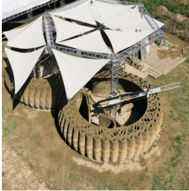
Resim 3. İtalyan tasarım ekibi WASP'ın geliştirdiği üç boyutlu yazıcı ile üretilen TECLA ev prototipi ve duvar yapısı, (URL 17).
