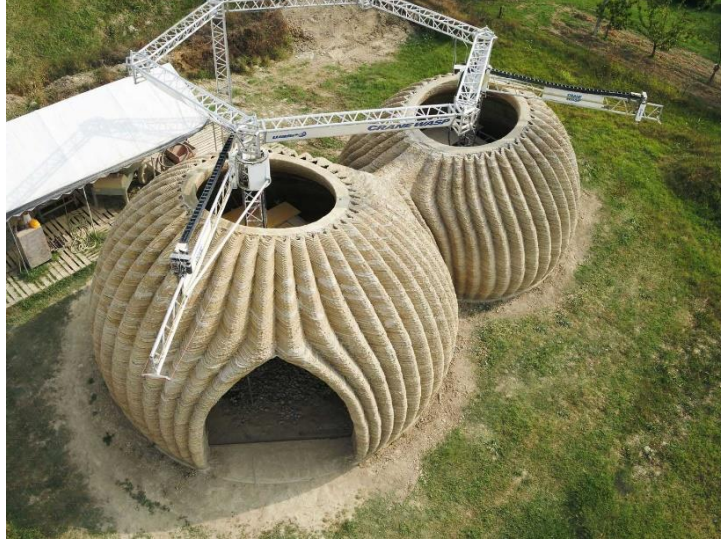
Resim 2. İtalyan tasarım ekibi WASP'ın geliştirdiği üç boyutlu yazıcı ile üretilen TECLA ev prototipi, (URL 16).
